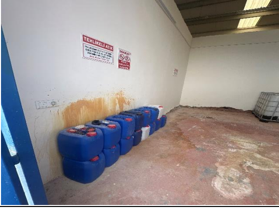
Fotoğraf 5.9. Tehlikeli ve Tehlikesiz Atık Depolama Odalarından Görünüm
