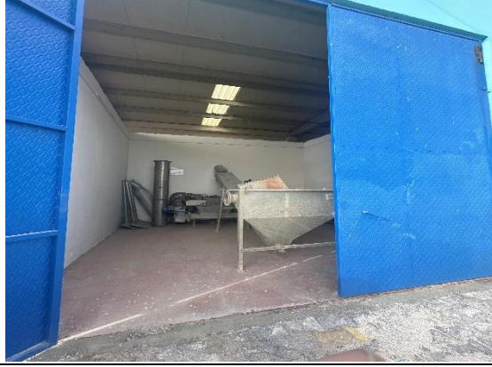
Fotoğraf 5.10. Tehlikeli ve Tehlikesiz Atık Depolama Odalarından Görünüm
